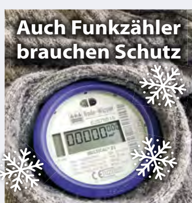
Gut eingepackt vermeiden Sie teure Reparaturen, denn die Kosten für einen Frostschaden trägt der Kunde.
