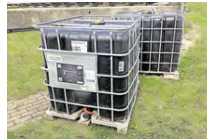
Das flüssige Nanocarbon wird in die Belebungsbecken dosiert. Foto: SPREE-PR/Wolf
