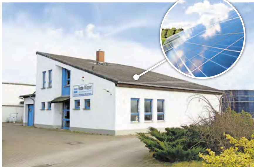
Der WAZV plant auf dem Dach des Betriebsgebäudes der Kläranlage Solarpaneele zur Stromerzeugung. Dies soll u. a. die Betriebskosten senken.
