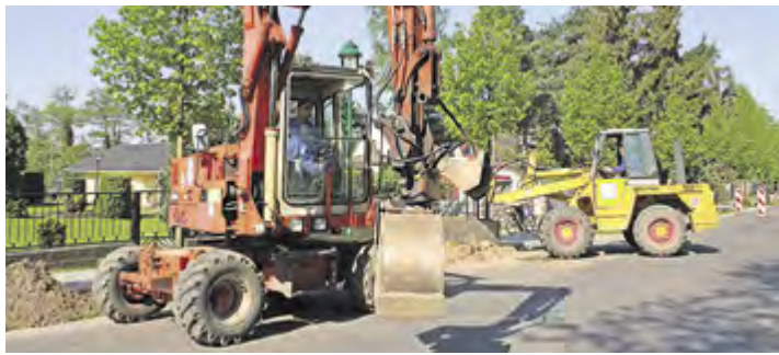
Schon bald rücken die Baufahrzeuge an: Unter anderem steht der Austausch der 90 Jahre alten Bleileitungen an.
