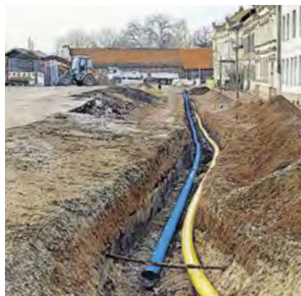
Erfolgreicher Abschluss 2024: die Versorgungsleitung in der Gollnowstraße in Staßfurt.
